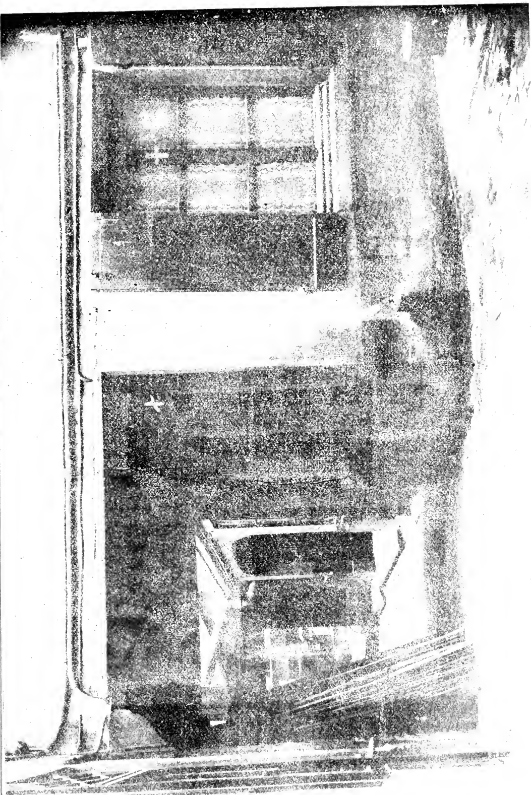
LE PIED NÉCROLOGIQUE DE L'INTERNATIONALE. 14. RELIEF DES GRAVILLÈRES. — ÉTAI ACTUEL. — La fenêtre et la porte sont marquées d'une croix
